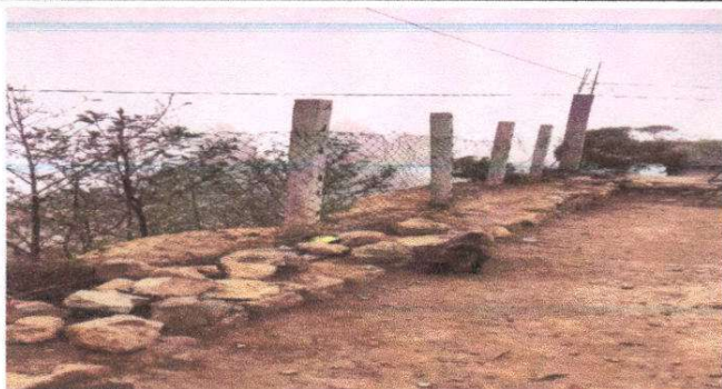
Foto 1: Reparación de tubo HG y malla galvanizada
